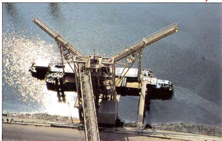
Un poste de déchargement des penches au port de Rouen.
